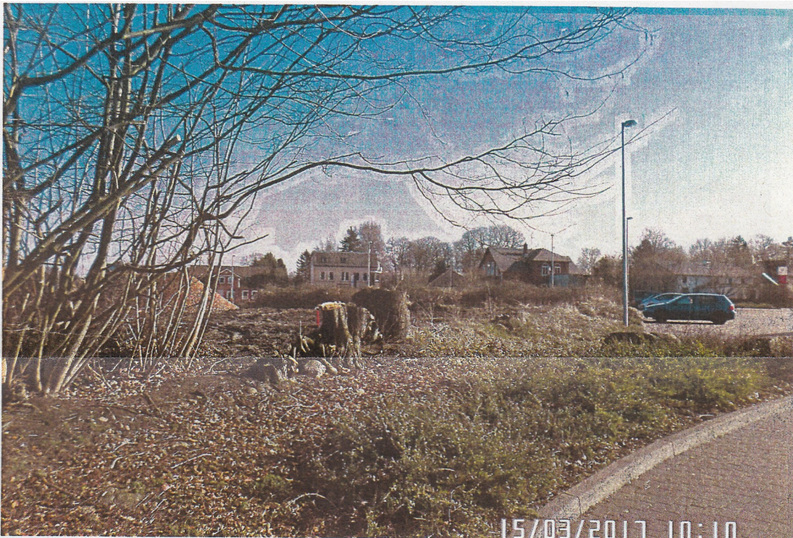
Bild 5 (Quelle: Kreis Rendsburg-Eckernförde): Nach Baufeldräumung, Blick vom Fußweg Aldi-Sky auf die Südseite des Plangebiets
