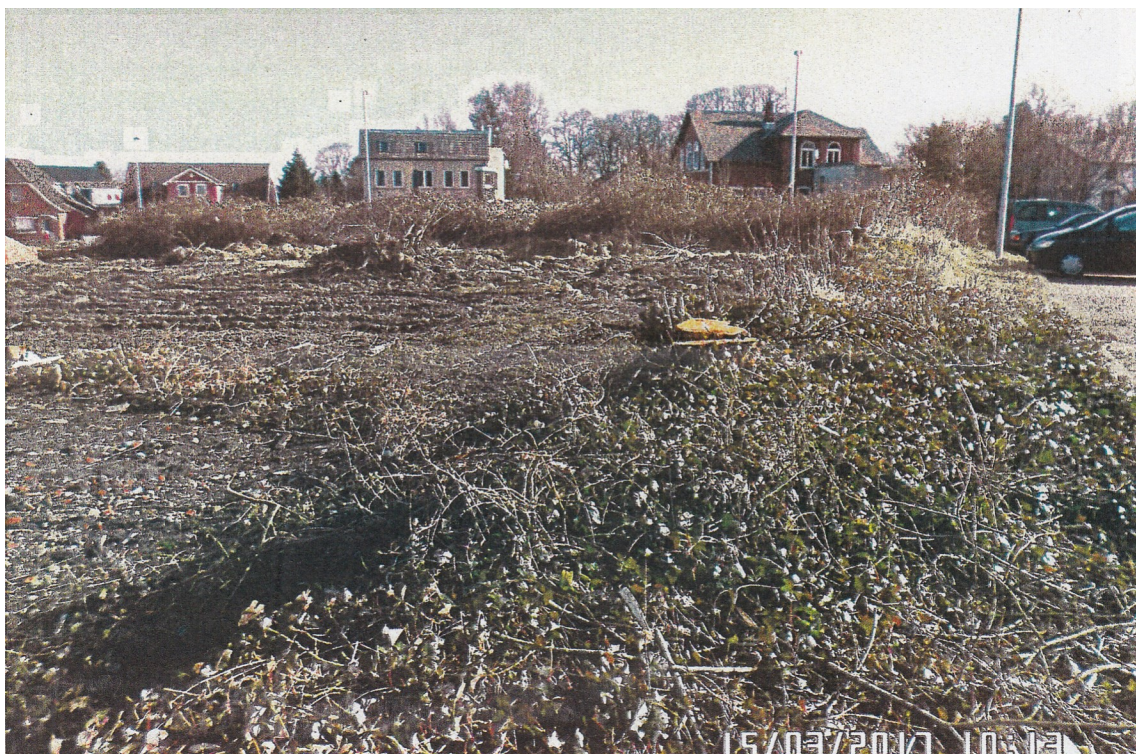
Bild 6 (Quelle: Kreis Rendsburg-Eckernförde): Nach Baufeldräumung, Blick entlang Süd-Ost-Seite des Plangebiets Richtung Theodor-Storm-Straße (ähnlich Bild 2)
