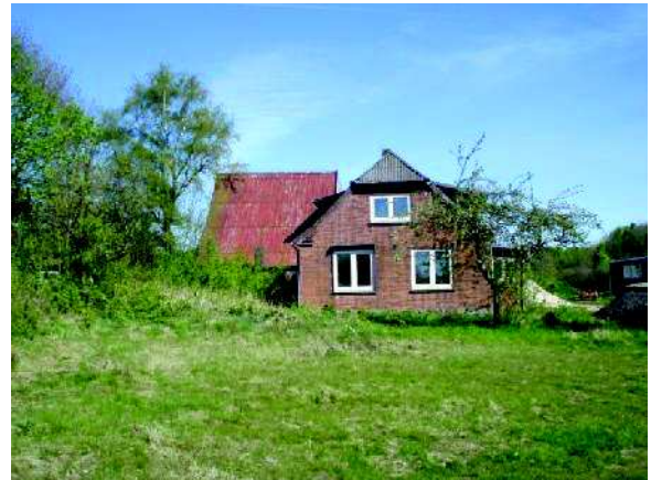
Abb. 35d Abgängiges Wohngebäude eines ehem. landwirtschaftl. Betriebes mit seitlichem Obstgarten (2)
