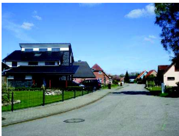
Abb. 37f Blick in den „Mühlenweg“ mit der (16) westlichen Bebauung ohne weitere Nachverdichtungsmöglichkeiten
