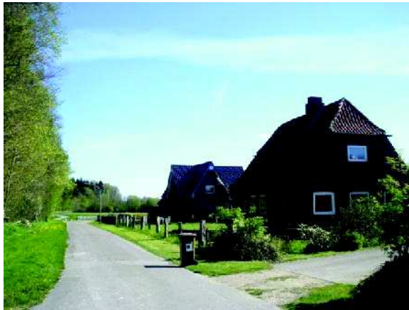
Abb. 35c Abgängiges ehem. Wohngebäude mit „Baulücke“ am Wald gelegen (1)
