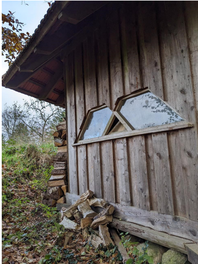
Abbildung 12: Einflugmöglichkeit in das als Holzlager genutzte Gebäude
